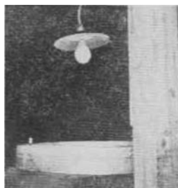
ホクト電球工業株式会社製青色電球 100W (連続スペクトル 6300 Å~3180 Å)
