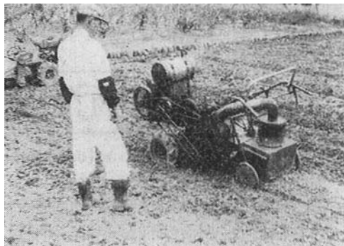
第4図 ハンドトラクター形式火焰焼土器の作業状況
