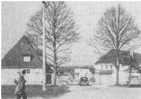
門の奥の建物：植物病理中央試験場 Station Centrale de Pathologie Végétale。 右の建物：新築の本館，事務室，図書室，食堂，講堂，娯楽室などがある。 左の建物：守衛所
