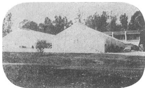
カリホルニア大学柑橘試験場殺虫剤関係実験室 (温室と実験室が直結している)
