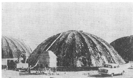
第7図 キプロスのテシファン型サイロ
