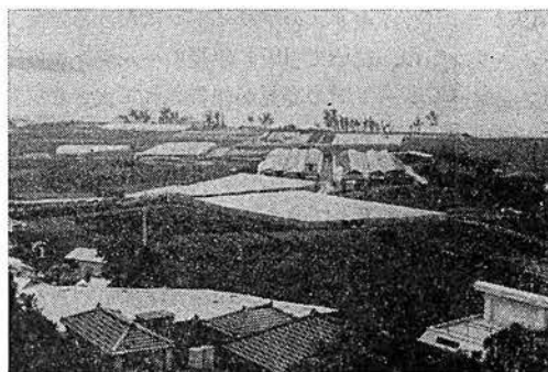
第5図 タフベル®の設置状況
