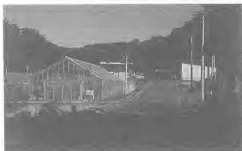
大島園芸技術センター施設と本館 (奥)
