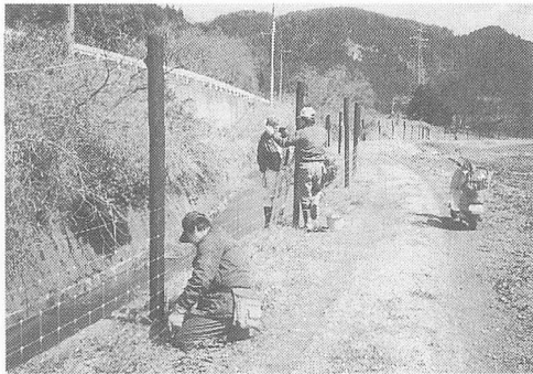
電気柵の設置状況
