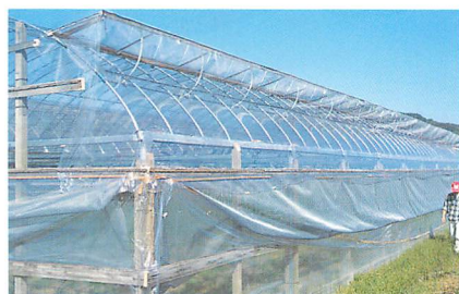
③防虫ネットの設置状況
