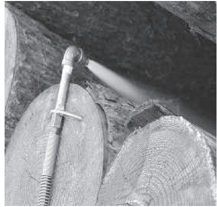
図-4 噴射時の圧力でノズルが動かないよう木口にカスガイでしっかり固定する
