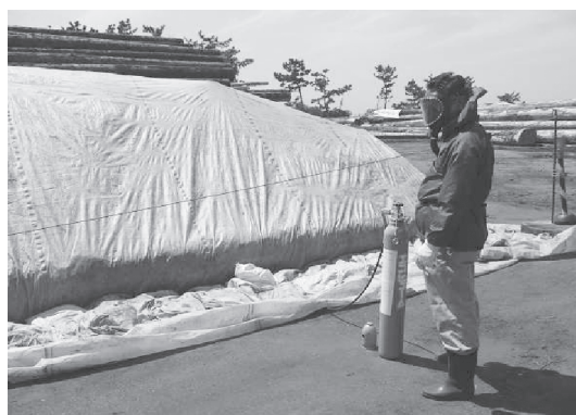
図-2 エコヒュームのくん蒸は、隔離式全面型防毒マスク (有機ガス用吸収缶) を着用して行う
