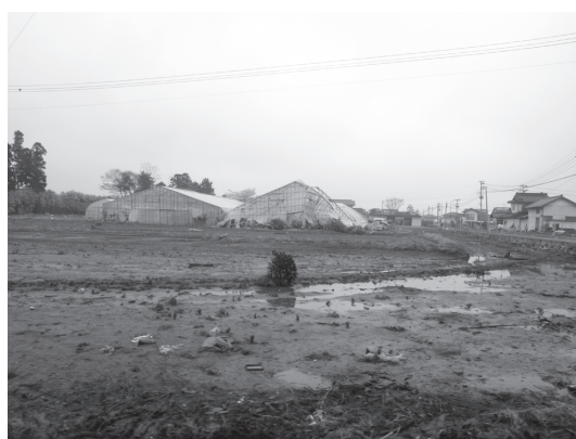
図-3 津波で壊れた大型パイプハウスと水田内に侵入したがれきや泥土 (2011年4月22日撮影)
