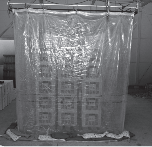
図-2 天幕の設置状況
