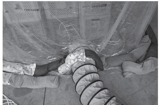
図-5 排気ダクトの設置状況
