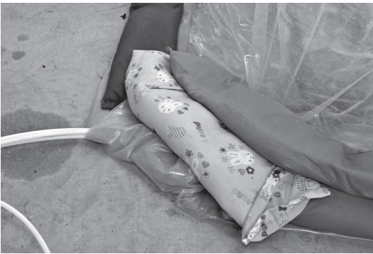
図-3 コード引出し部の砂のう設置状況
