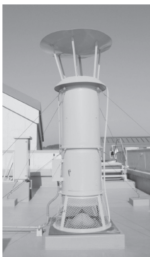
図-2 ジョンソン・テイラー型吸引トラップ (大型吸引トラップ)
