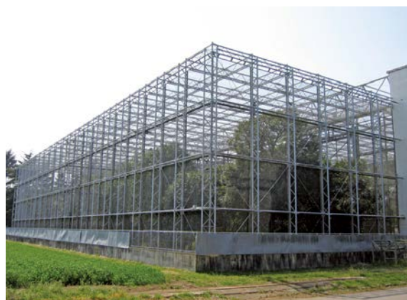
図-2 中央農業研究センターに設置されている鳥害対策実験用の大型ケージ 長さ 60 m, 幅 40 m (写真はその半分), 高さ 12 m.
