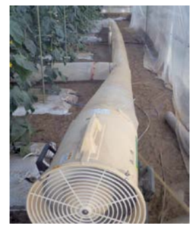
図-6 ダクトホースの設置状況 ダクトホースは上部に穴が空いており、1本設置は100m当たり270穴、2本配置は140穴を使用した。
