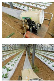
図-6 ダクトホースの設置状況 ダクトホースは上部に穴が空いており、1本設置は100m当たり270穴、2本配置は140穴を使用した。
