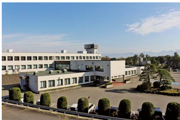
研究棟・管理棟の外観
